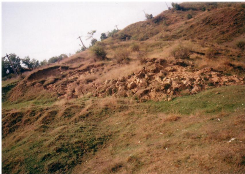
Alunecări de teren în primăvara-vara anului 2004 – zona Brătești.
